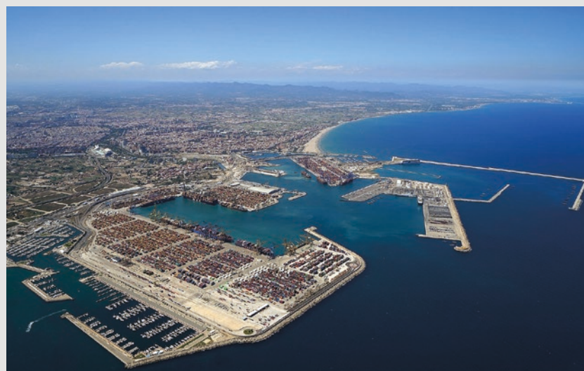
El Puerto Valencia dispone de más de 3.700 conexiones frigoríficas (reefer) en sus terminales.
