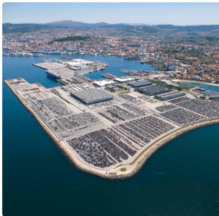
► En el Puerto de Vigo, la Autoridad Portuaria ha instalado un sistema OPS en la Terminal Ro-Ro de Bouzas.
