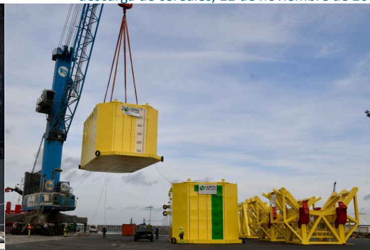
Carga de piezas metálicas, 5 de abril de 2018
