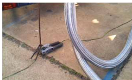
Fig. 10. Puesta a tierra de cisternas de GNL antes del trasvase. (Foto cortesía de ESK)
