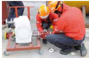
Conexiones con válvula para bombeo. Colocación válvula de seccionamiento. Circuito cerrado de bombeo
