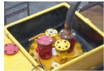
Conexiones con válvula para bombeo. Colocación válvula de seccionamiento. Circuito cerrado de bombeo
