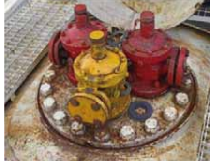
Válvulas tipo Phoenix (gases)
