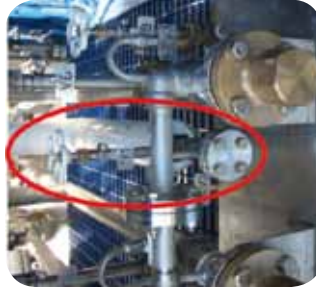
VÁLVULAS DE VACIADO DE EMERGENCIA
