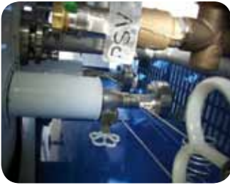
VÁLVULAS DE VACIADO DE EMERGENCIA
