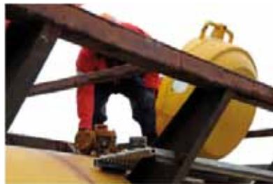
Tapa de protección de valvulería o domo.
