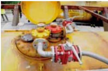
Conexiones con válvula para bombeo. Colocación válvula de seccionamiento. Circuito cerrado de bombeo
