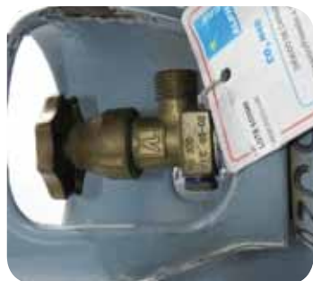
CO2 CON DISCO DE ROTURA ( a 80 Kg/cm 2 )
