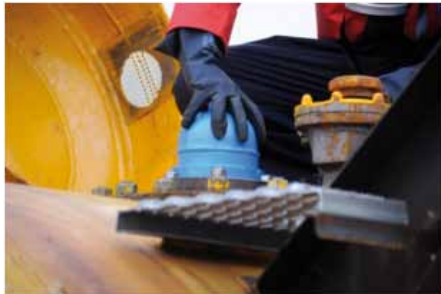
Colocación del CAP sobre la válvula de sobrepresión.
