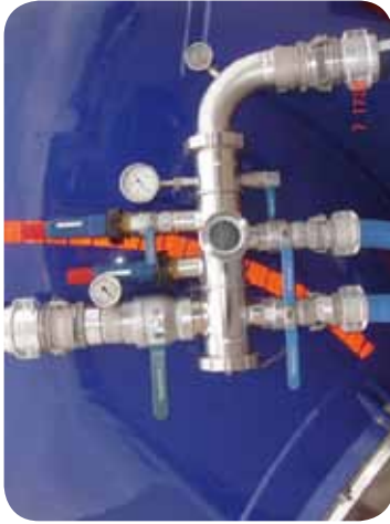
COLECTOR DE PRESIÓN CON VÁLVULA DE SOBREPRESIÓN
