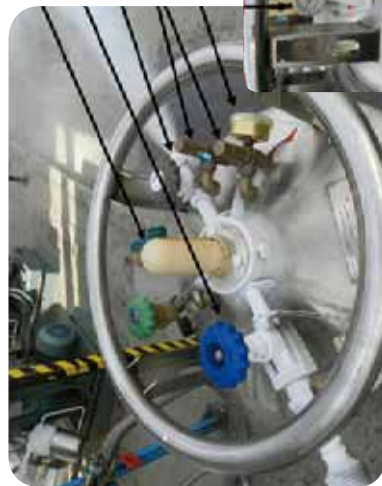
NIVEL DE LÍQUIDO VÁLVULA FASE LÍQUIDA VÁLVULA FASE GAS VÁLVULA SOBREPRESIÓN MANÓMETRO
