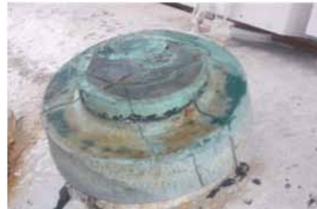
Válvula encofrada con cemento.
