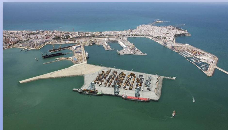
Puerto de Cádiz. Nueva terminal de contenedores
