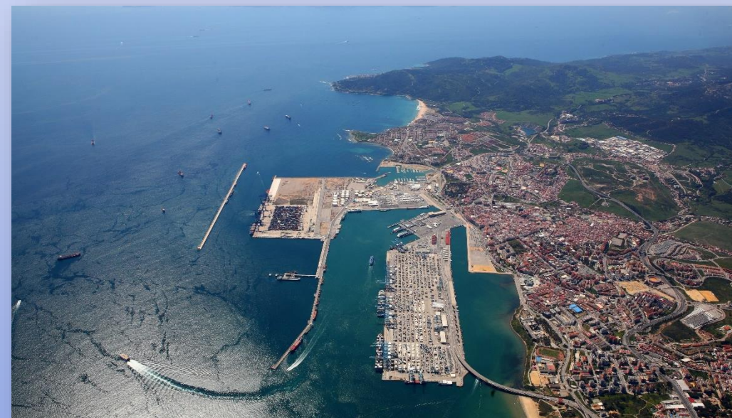
Puerto de Algeciras. Vista general.
