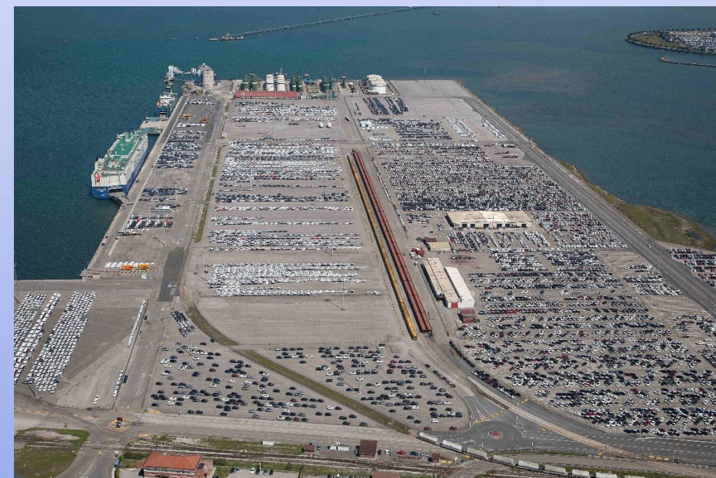
Puerto de Santander. Terminal de Raos para carga rodada
